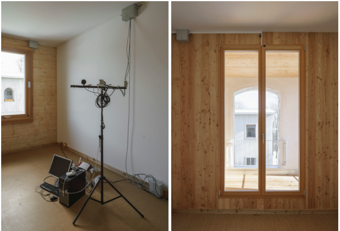
Abbildung 48: Sensor-Installation im Holzhaus; 1-Zi-Ost-Wohnung (links): Sensor-Stativ mit Datentransfereinheit (PC, Monitor, Router); Süd-Wohnung (rechts): Fensterkontakt an Loggia-Türe mit Kabelkanal zum Knotenpunkt
